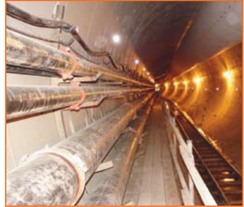
14" und 16" R-88 Kupplungen im Eastside Mischwasser- und Überflutungs-Tunnelbohrprojekt - Portland, Oregon, USA
