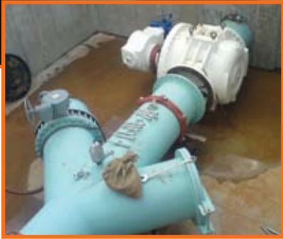
48" R-88 Kupplungen in einer Wasseraufbereitungsanlage – Ouray Utah, USA
