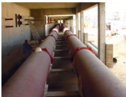
30" Kühlwasserleitungen
