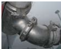
SS 304 Trinkwasserleitung
