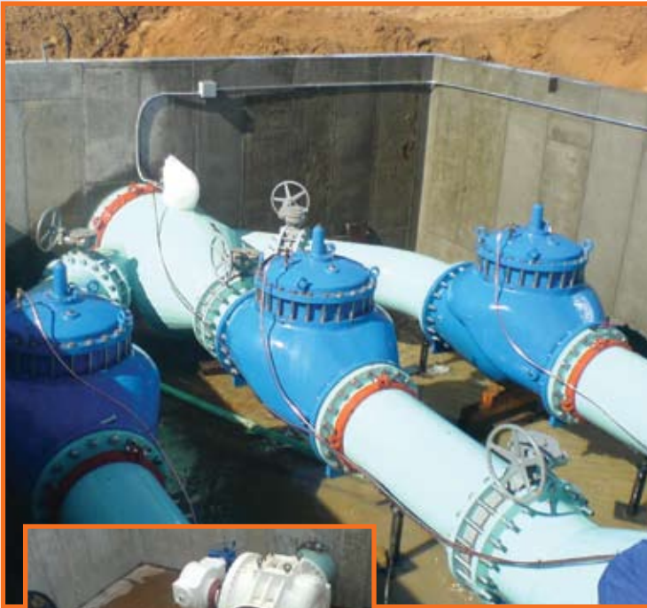
48" R-88 Kupplungen in einer Wasseraufbereitungsanlage – Ouray Utah, USA
